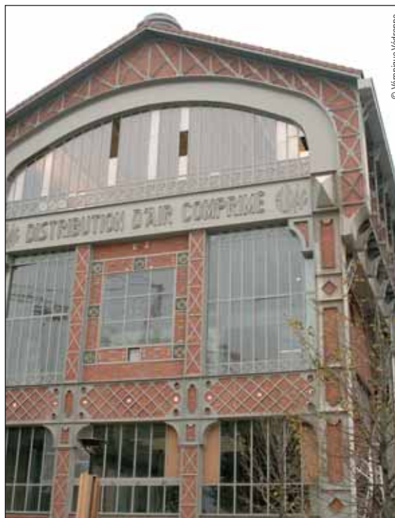
Bâtiment de la SUDAC, future école d'architecture. En cours de réhabilitation.
